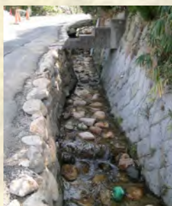
平成16年2月 おぜ川改修工事
