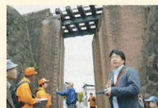
明治のレンガ積橋台
